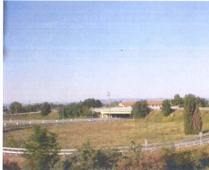
VISIBILITA' SVINCOLO AUTOSTRADALE
